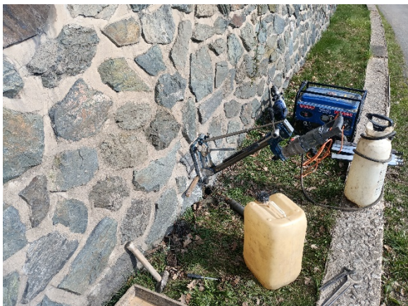
Foto 1: Umístění a realizace diamantově vrtané sondy S1.
