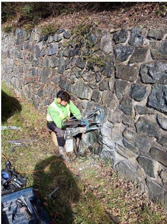
Foto 8: Umístění a realizace diamantově vrtané sondy S5.
