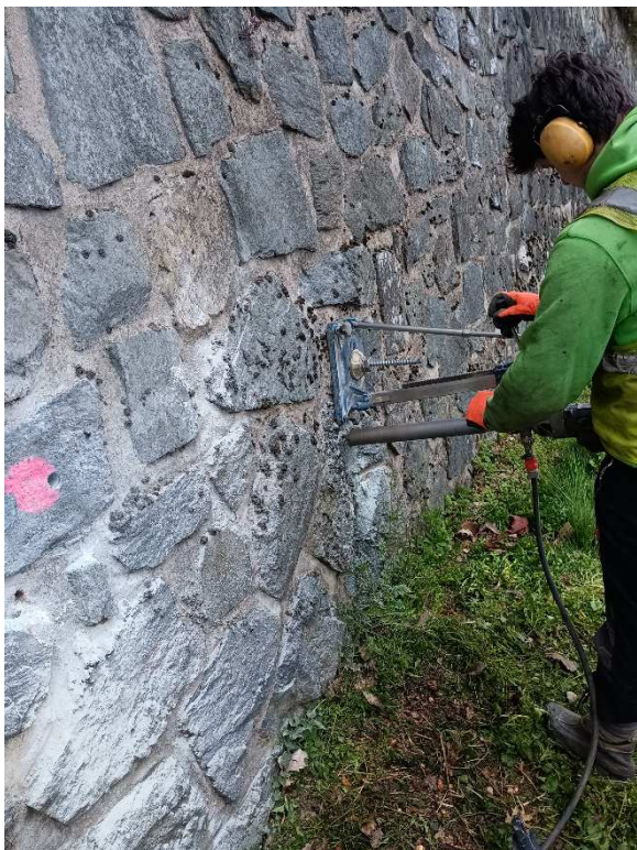
Foto 5: Umístění a realizace diamantově vrtané sondy S3.
