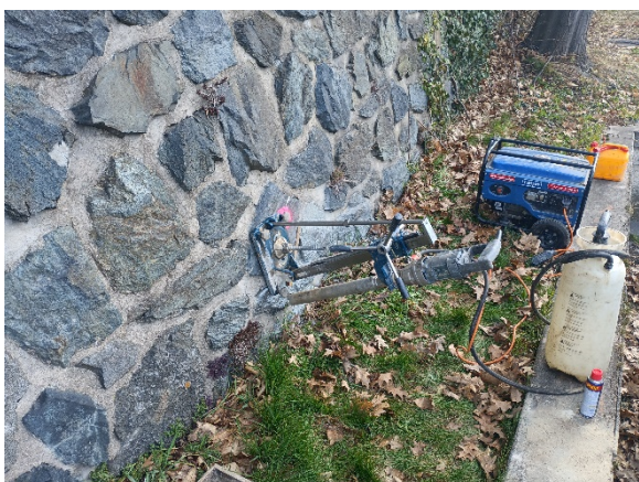
Foto 3: Umístění a realizace diamantově vrtané sondy S2.
